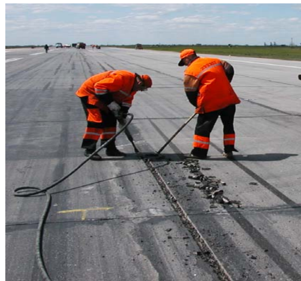
Устройство камеры пропилом
