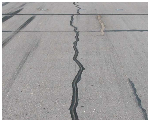
Схема герметизации камеры трещины и прилегающей зоны асфальтобетонного покрытия.
