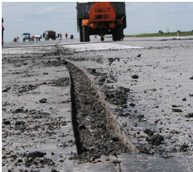
Камера, устроенная фрезой «Bobcat»
