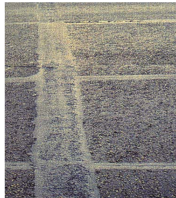
Общий вид залитой трещины с гидроизоляцией кромок.
