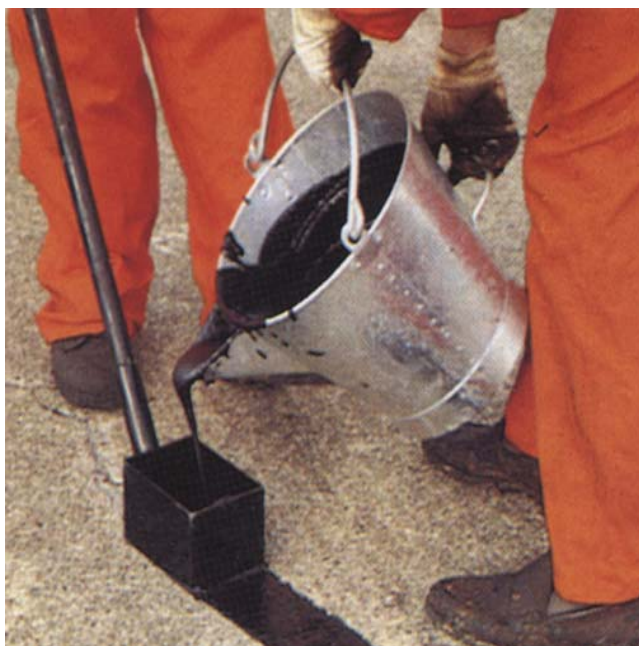
Заливка трещин с использованием шаблона.
