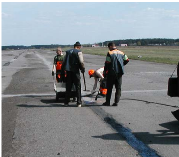
Отделка поверхности деформационной вставки.
