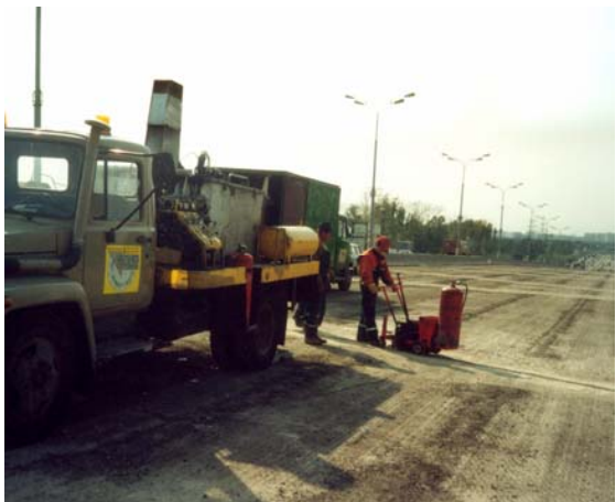
Схема герметизации трещин на сопряжениях, с гидроизоляцией асфальтобетона на прилегающих кромках.
