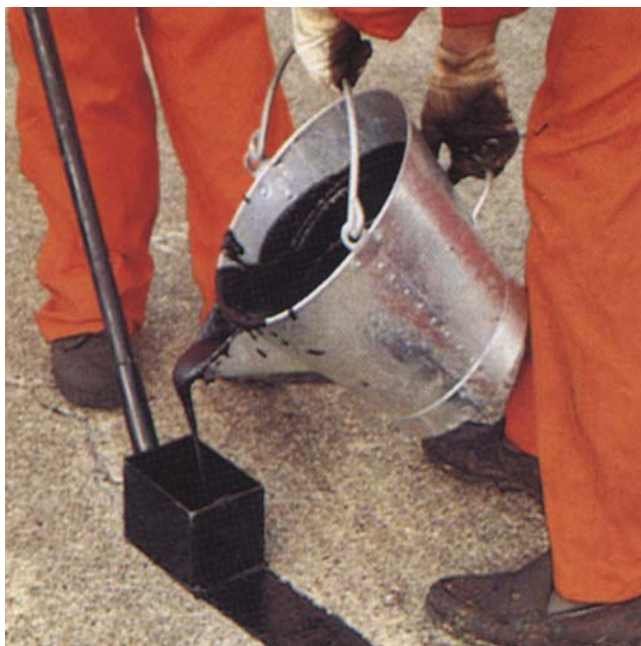
Заливка трещин с использованием шаблона.
