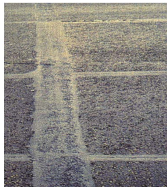
Общий вид залитой трещины с гидроизоляцией кромок.
