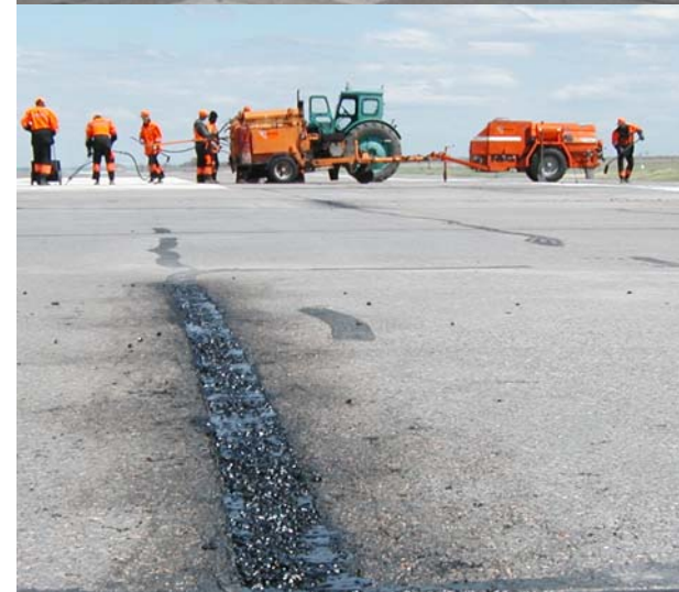
Укладка щебне-мастичной смеси в камеру.
