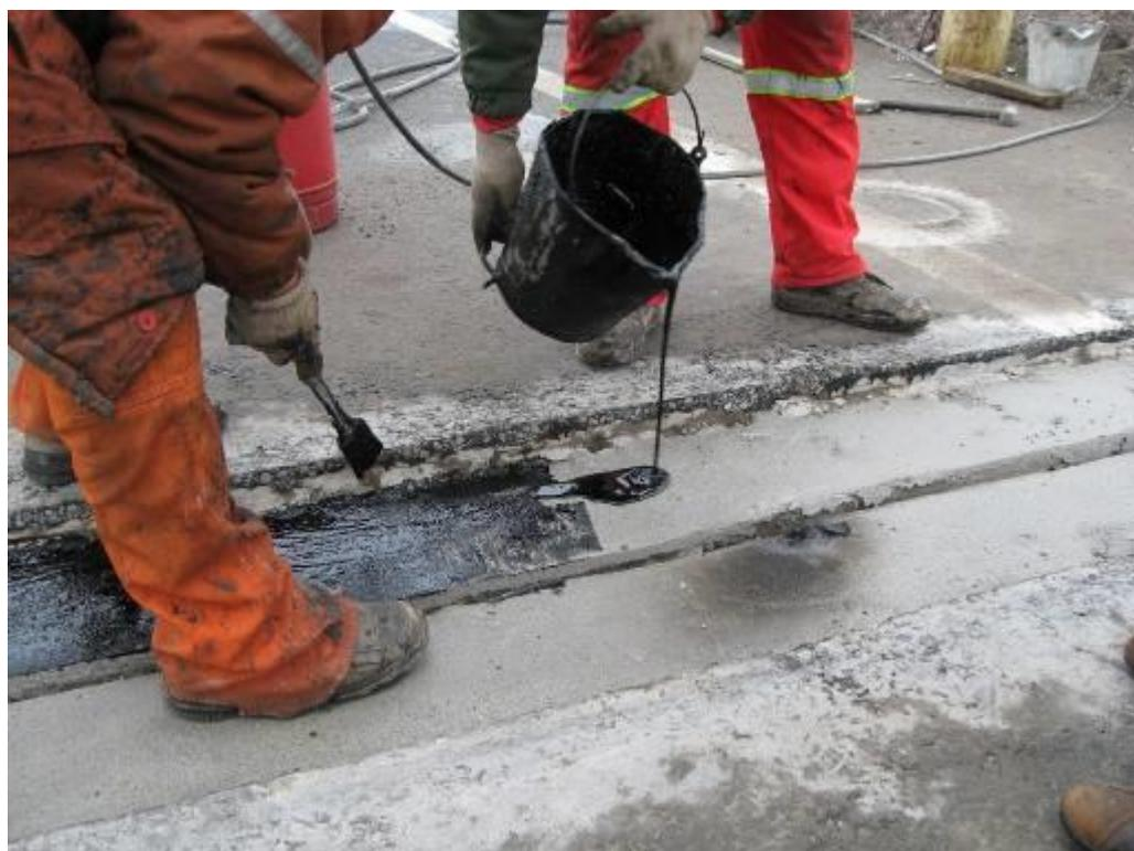
***Рис.11. Грунтование дна шва***
