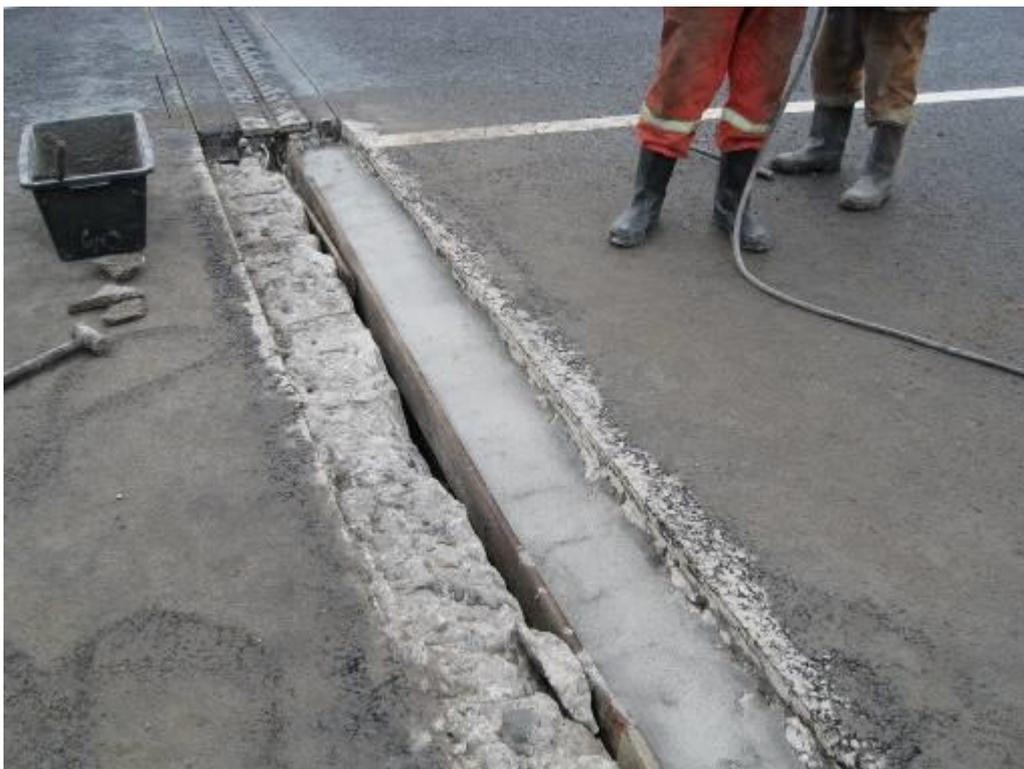
**Рис.9. Устранение дефектов защитного слоя.**
