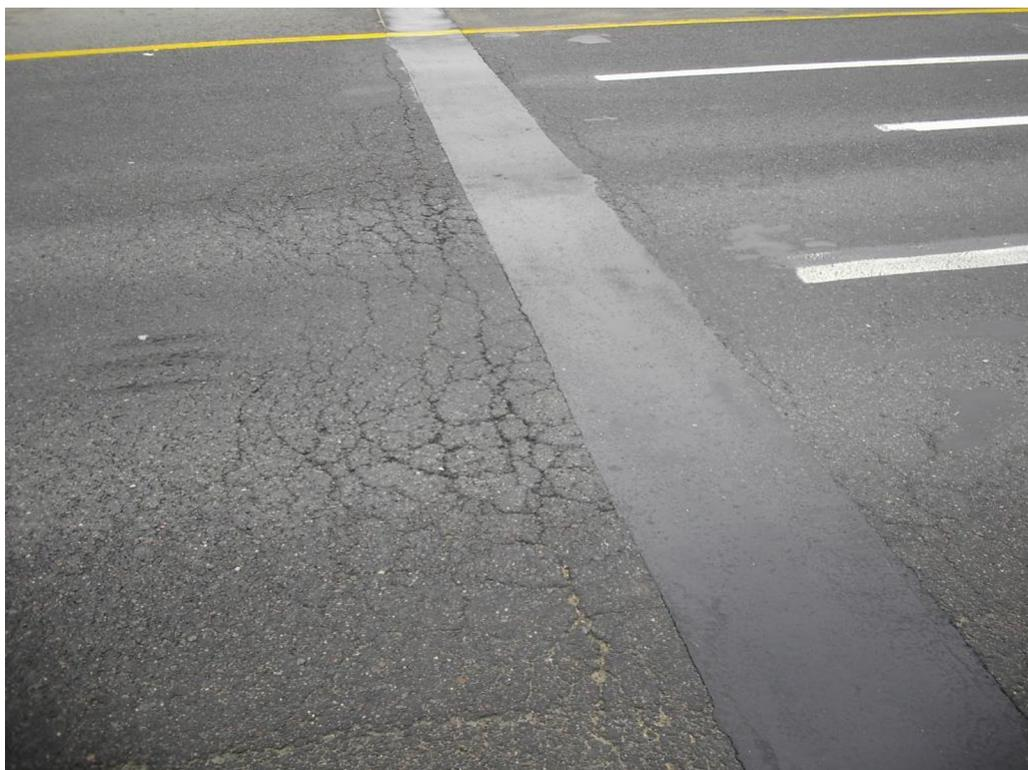
***Рис.27. Разрушение асфальтобетонного покрытия в зоне ЩМДШ***
