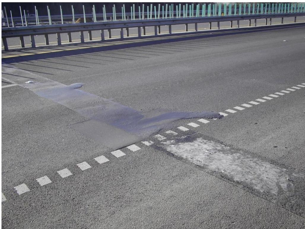
**Рис.24. Выдавливание щебеночно-мастичного заполнения из полости шва**
