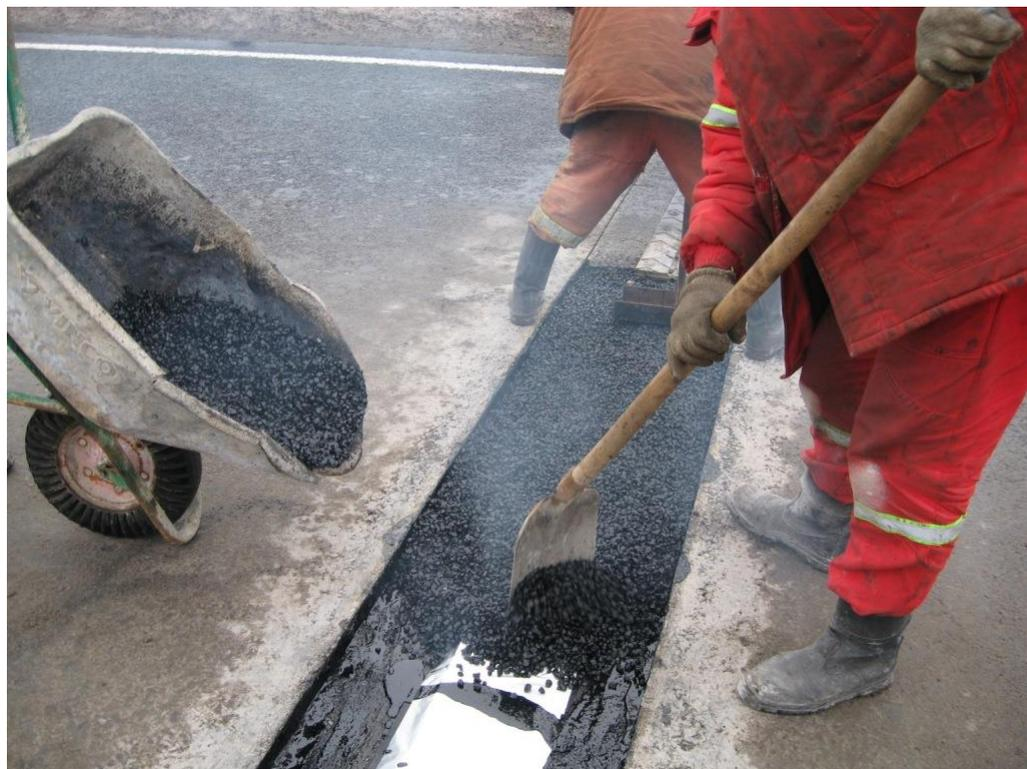
**Рис.16. Заполнение полости шва разогретым и обработанным щебнем.**
