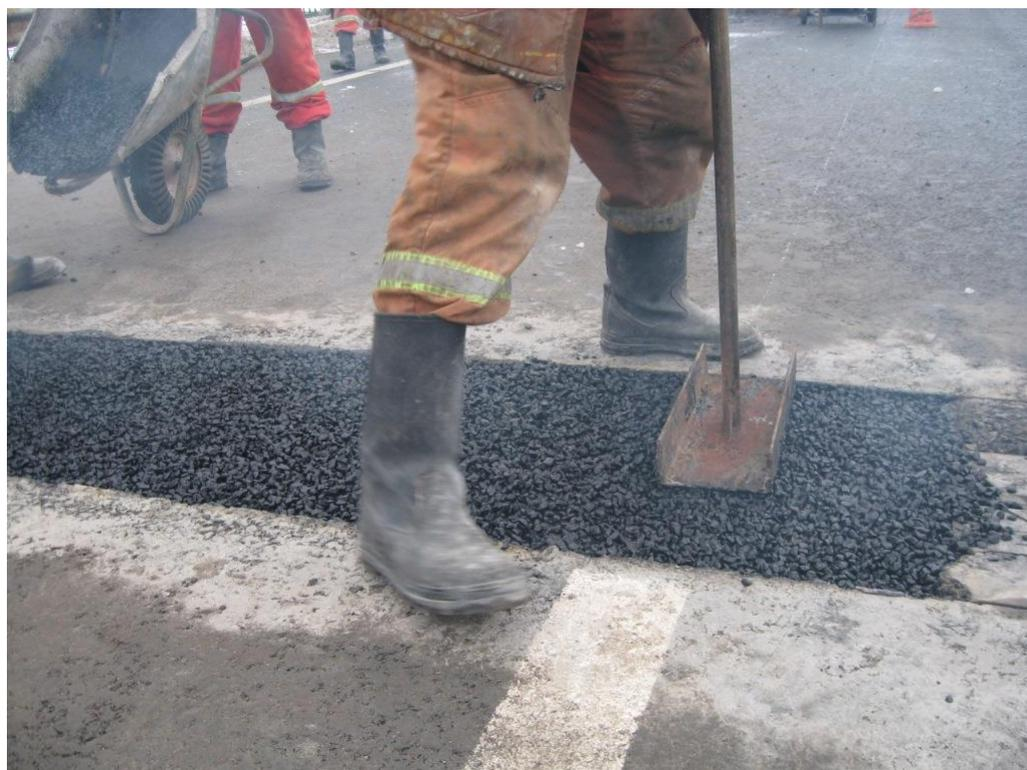
***Рис.18. Уплотнение слоя щебня фр.5-10мм ручной трамбовкой.***
