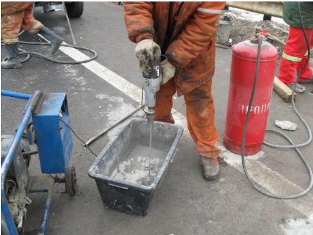
**Рис.8. Приготовление быстротвердеющей смеси «EMACO» T545**
