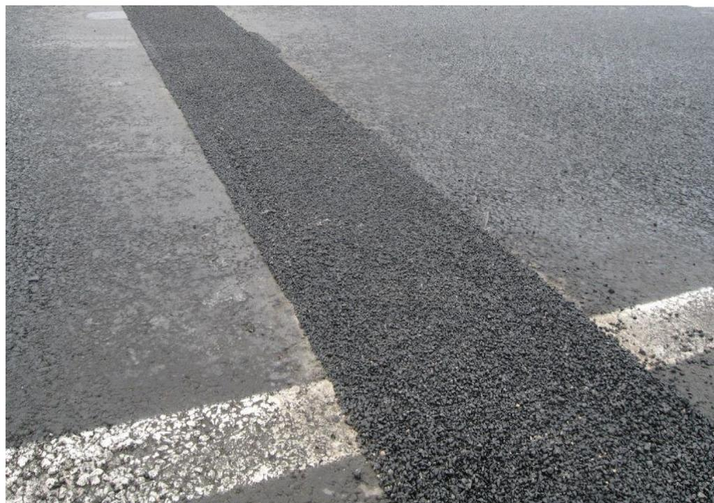
***Рис.22. Общий вид готового ЩМДШ.***
