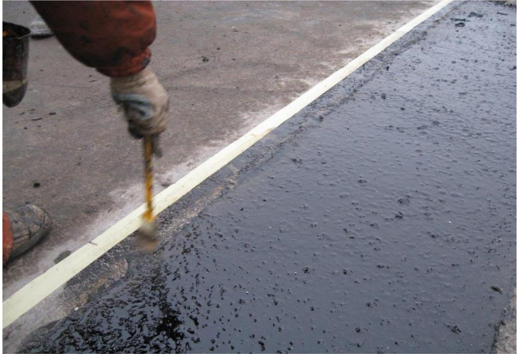
**Рис.19. Огрунтовка кромок шва.**
