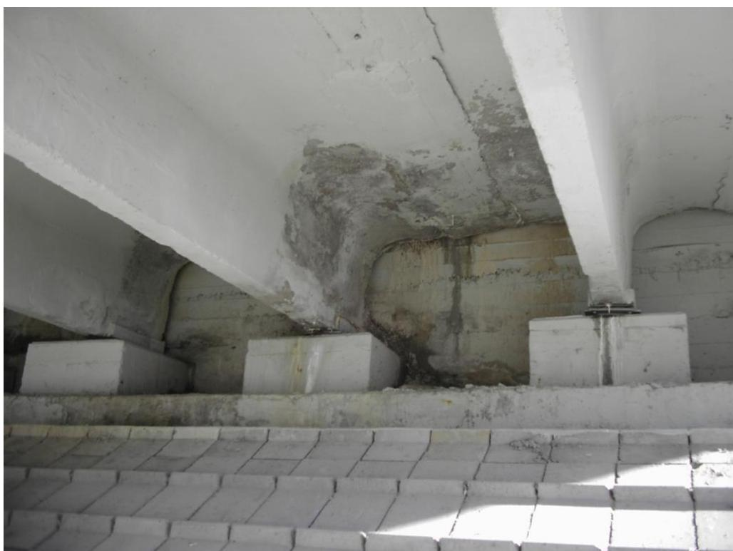
**Рис.25. Проникновение влаги на опорные конструкции.**
