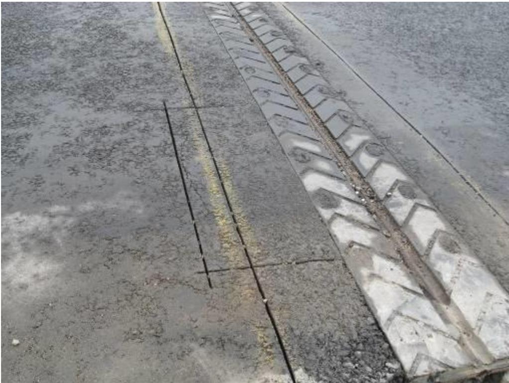
**Рис.7. Нарезка шва с учетом локальных дефектов покрытия в зоне ДШ**
