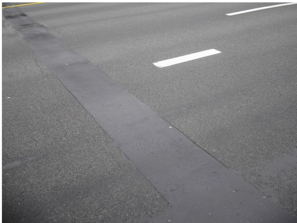
***Рис.23. Локальные отрывы щебеночно-мастичного заполнения от стенок шва.***
