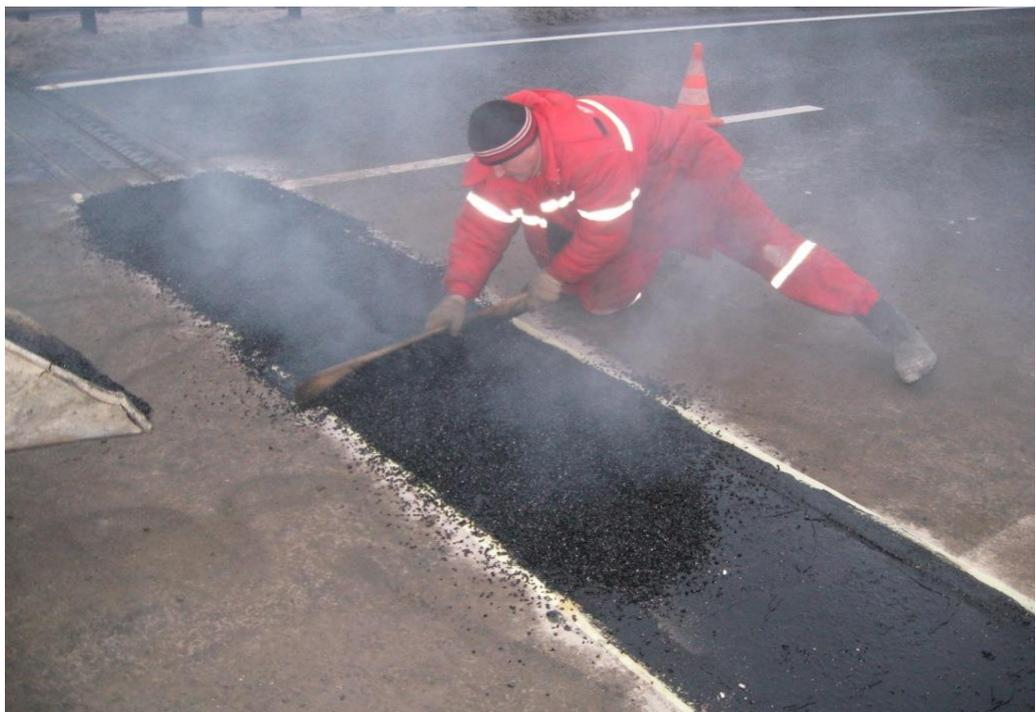
**Рис.20. Распределение щебня фр.3-5мм.**
