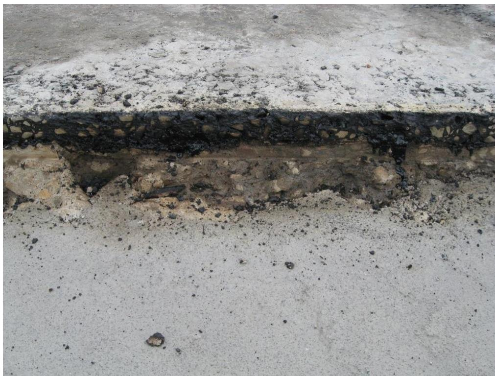
***Рис.28. Перегрев поверхности асфальтобетона.***
