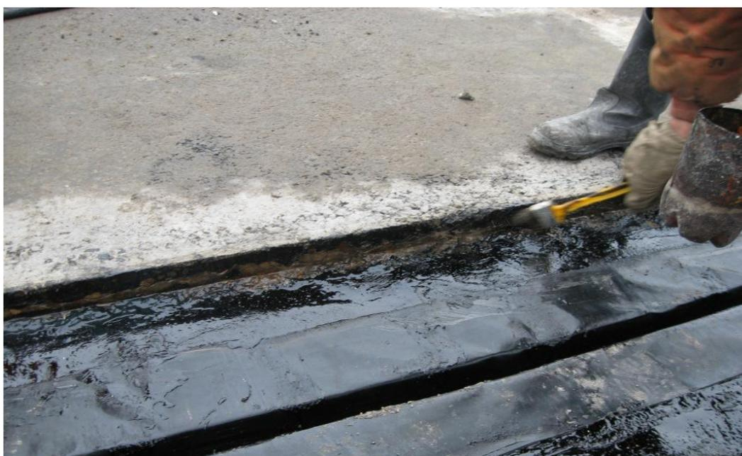
**Рис.13. Грунтование стенок шва**
