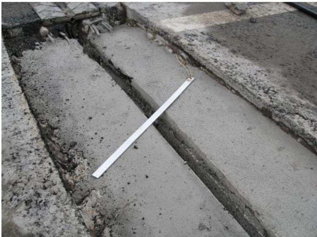
***Рис.10. Выравнивание продольного профиля шва***
