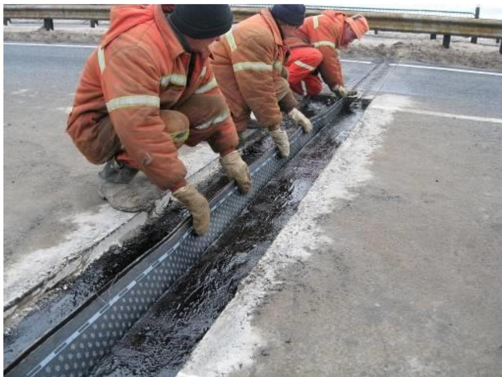
**Рис.12. Установка компенсатора**
