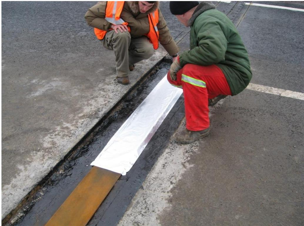
**Рис.14. Установка опорных пластин и укладка алюминиевой фольги.**
